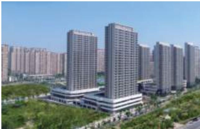
工程主体结构预制构件共计6种6252件,预制率达31.31%;围护构件采用钢筋陶粒混凝土轻质墙板、ALC外墙板;装饰装修采用装配式装修,共计432套。本项目预制装配率达60.67%。
