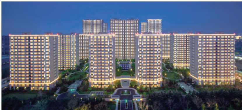
日钢绿城·理想之城项目(詹天佑金奖住宅小区)
