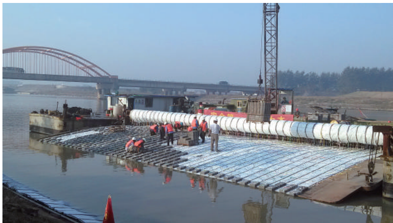
河道工程软体沉排施工
