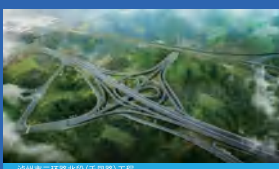
泸州市二环北路(干洪路)工程
