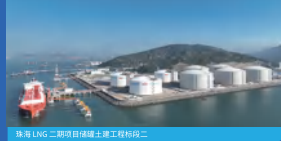
珠海 LNG 二期项目储罐工程标段二
