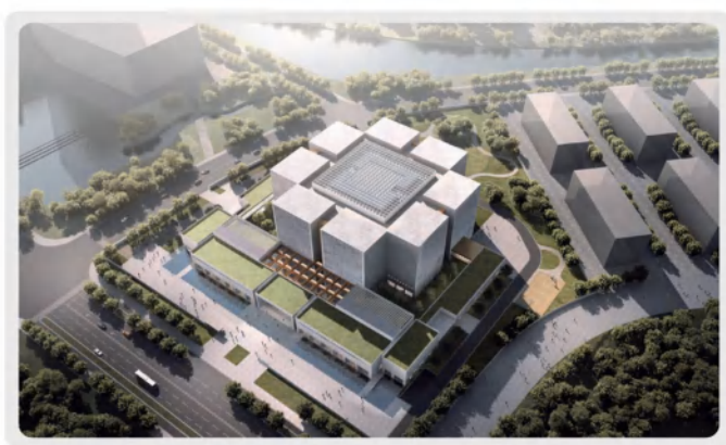
中国第二历史档案新馆项目
