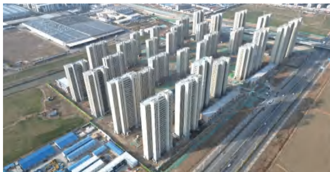
宿迁盛世东城（EPC）工程总承包项目建设现场 力打造现代、生态的城市环境。
