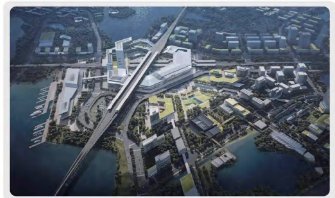
汾湖站交通枢纽配套工程地上工程
