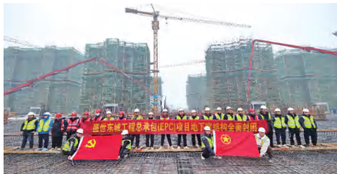
项目党支部在地下室结构建设阶段集结助力生产
